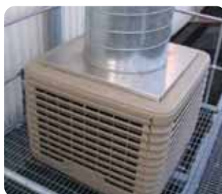
Installazione con uscita superiore
