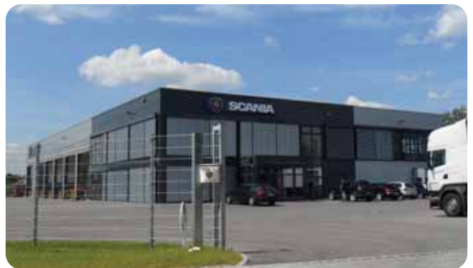
Oberschleißheim, Monaco - Germania
