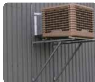
Installazione con uscita laterale
